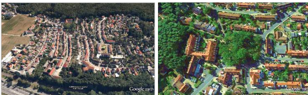
Luftaufnahmen: Geigenbauersiedlung aus Richtung Westen und Umfeld Eichenplatz mit Altenheim St. Franziskus (Quelle Google earth/ 4-2016)
