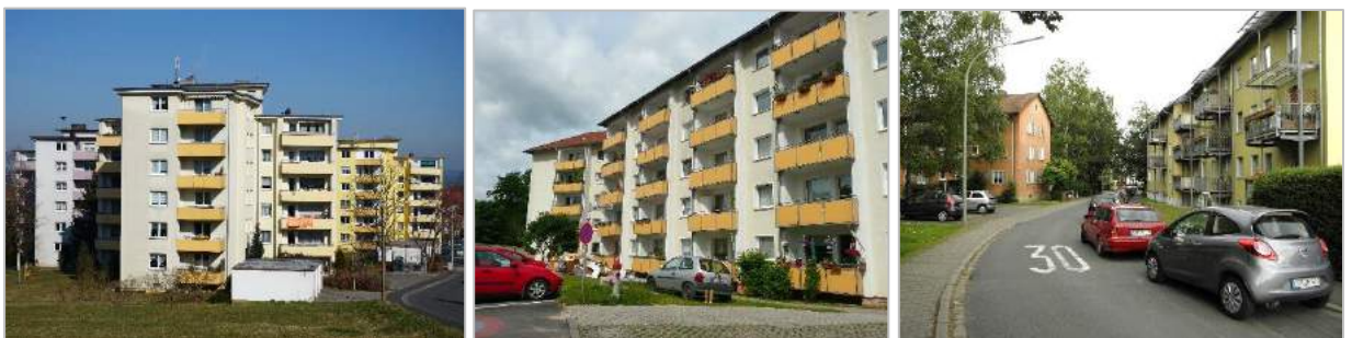
Fotos v. links nach rechts: Y-Häuser der Josephsstiftung an der Bergstraße und an der Damaschkestr., Geschosswohnungsbau der Genossenschaft im LK ERH in der Geigerstraße
