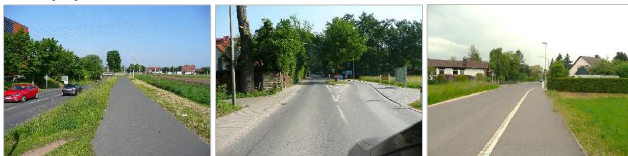
Fotos von links: aus Richtung Westen, S-Bahn/ aus Richtung Süden/ aus Richtung Norden
