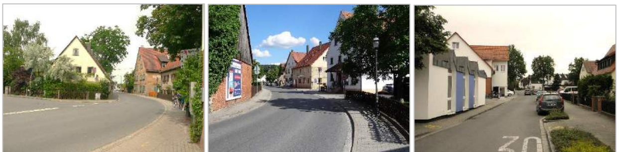
Fotos: Engstellen und unübersichtliche Straßeneinmündungen entlang von Haupt- und Binsenstraße
