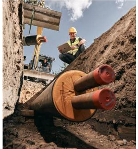
Foto: Ein Wärmenetz entsteht: Fernwärmeleitung in Straßengraben versorgt Abnehmer schon bald mit Wärme frei Haus.
