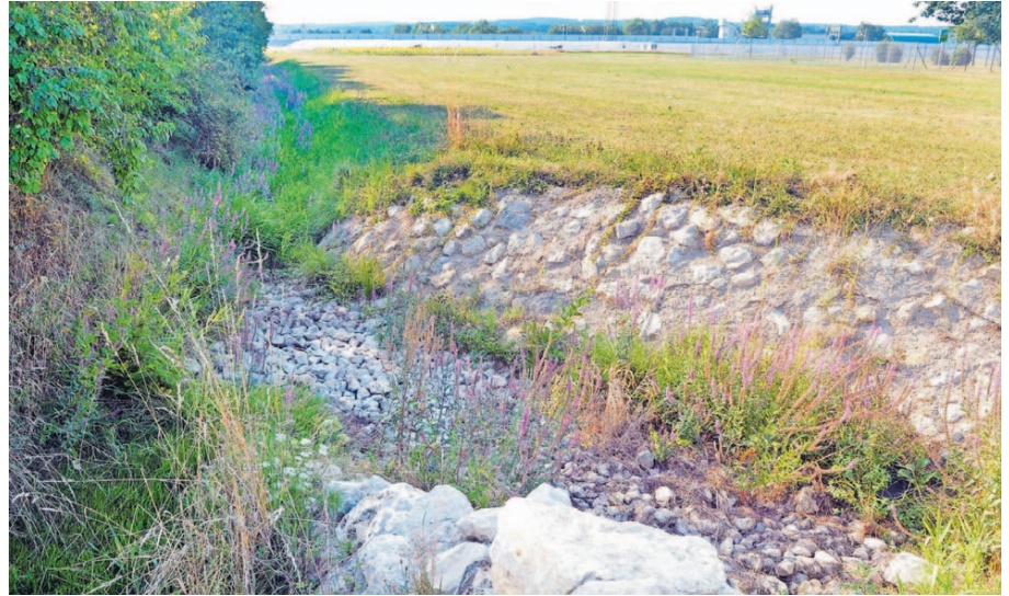
Bis zur Scherleshofer Straße (vorn) ist der Bubenreuther Hochwasserschutz bereits fertig, jetzt soll der Graben unter der Bahn (hinten) hindurch und weiter bis zur Regnitz geführt werden. Foto: Klaus-Dieter Schreiter
