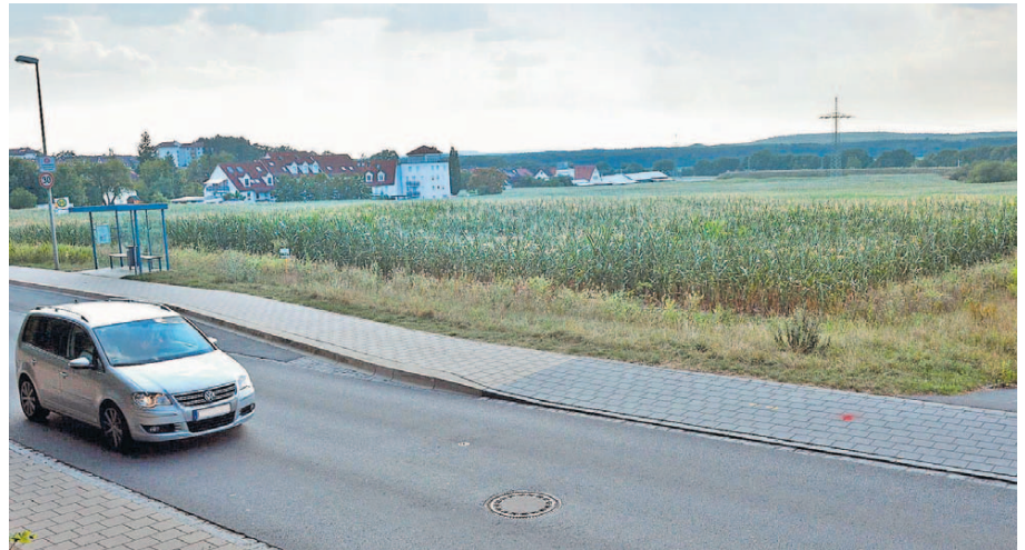
Der Bubenreuther Gemeinderat hat einen Nachtragshaushalt beschlossen, auch, um hier im Hoffeld zwischen Birkenallee (hinten) und Bahn Grundstücke erwerben zu können. Foto: Klaus-Dieter Schreiter
