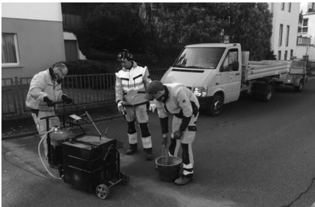
Einweisung unserer Bauhofmitarbeiter durch einen Kollegen aus Baiersdorf
