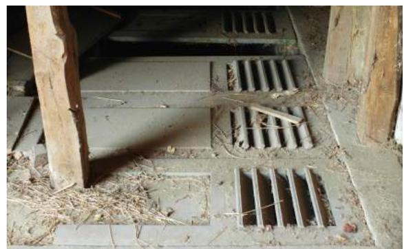
In der Scheune findet man zahlreiche Spuren der Wiederverwendung von Bauelementen. Viele Hölzer der Dachkonstruktion zeigen, dass sie ursprünglich an anderer Stelle, vielleicht sogar an anderen Gebäuden verbaut waren. Die Ziegelsichtfassade hat einen Sockel und Zierelemente aus Sandstein, die evtl. noch vom Vorgängerbau stammen. Dadurch harmoniert das Gebäude schön mit dem Sandstein-Wohnhaus.
