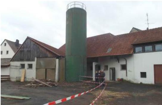
Die Konstruktionen, die sich aus den mehrfachen Umbauten ergeben haben, können z.T. als statisch gewagt betrachtet werden und sind keinesfalls für Umbauten geeignet.
