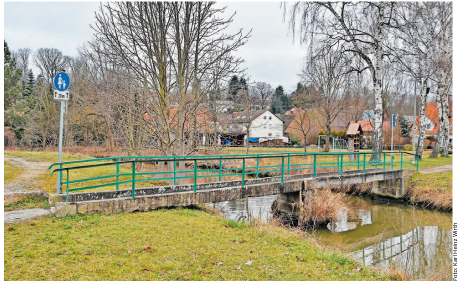
Die in die Jahre gekommene Brücke über den Seebach im Ortsteil Kleinseebach soll noch in diesem Jahr durch eine GFK Brücke ersetzt werden.
