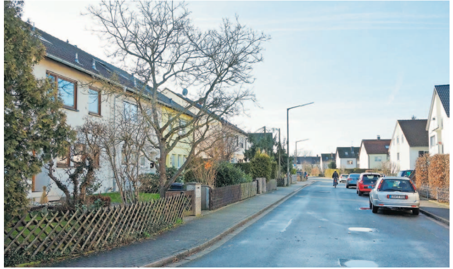
Die sogenannte Vogelsiedlung soll, sofern der Gemeinderat das beschließt, ein Untersuchungsgebiet und später vielleicht auch Sanierungsgebiet werden. Allerdings hätten die Bewohner dort bereits viel in die Modernisierung investiert, sagen einige Gemeinderäte. Foto: Klaus-Dieter Schreiter
